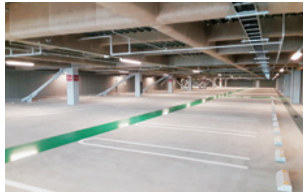
完成写真（内観）
