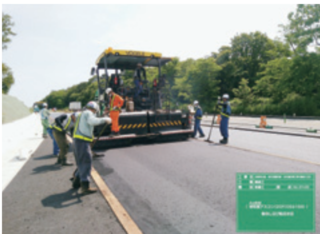
拡幅部表層工施工状況
