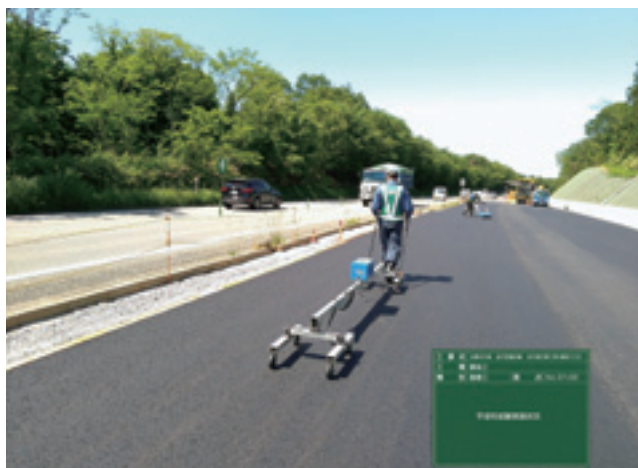
基層完了時の平坦性測定状況
