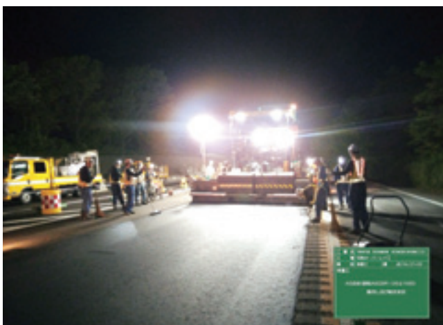
車線切替え時の現道部急速施工状況
