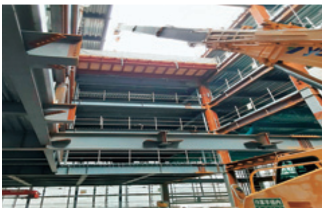
吹抜け部から資材揚重
