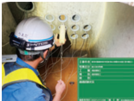
ストック管路品質確認状況
