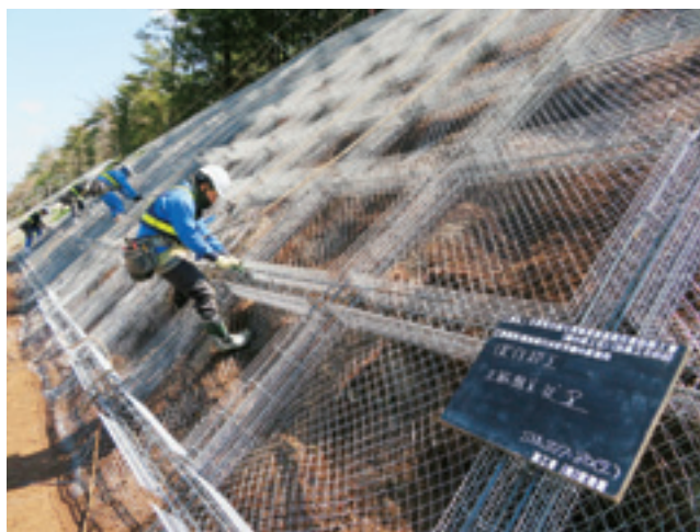
法枠組立状況
