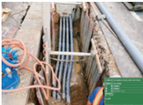
ストック管路接続状況
