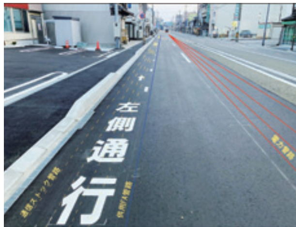
完成写真①
