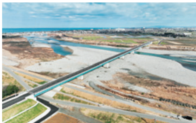
写真-2 川北能美大橋（小松側から金沢方向を望む）
