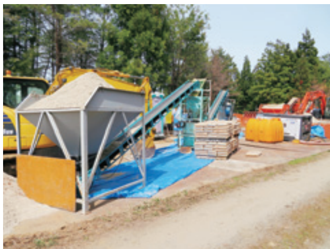
吹付プラント設置状況
