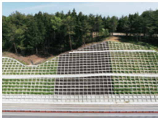
完成写真 正面から
