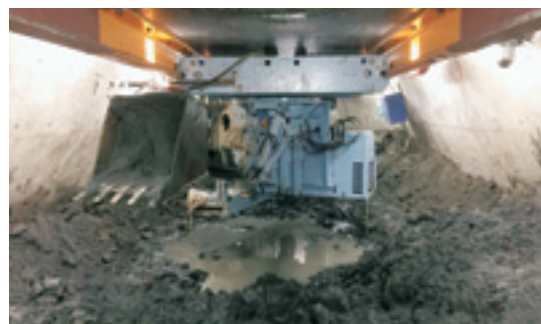
写真-1 ケーソンショベルの無人掘削作業
