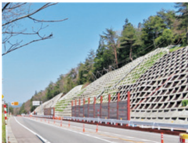
仮設防護柵設置状況
