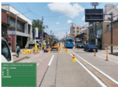
交通量の多い街中での工事
