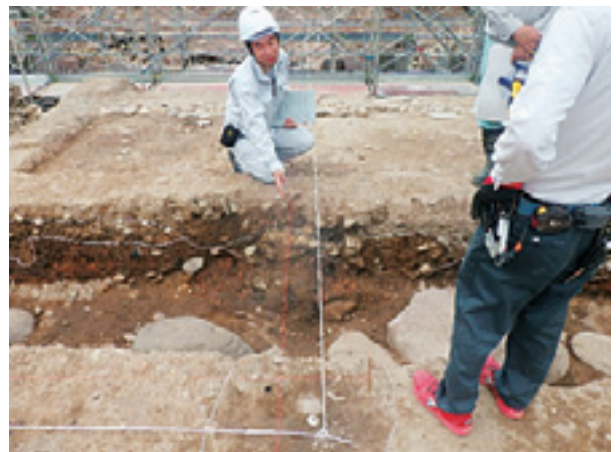
櫓位置確認状況
