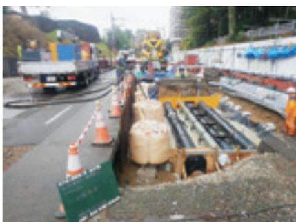
エアモルタル打設状況 P-4P-5橋脚下部 金沢市企業局埋設管鞘管
