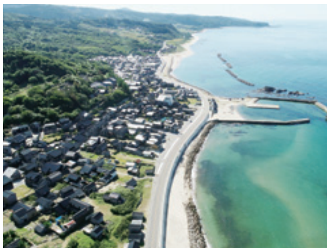
写真-3 整備後の黒島道路
