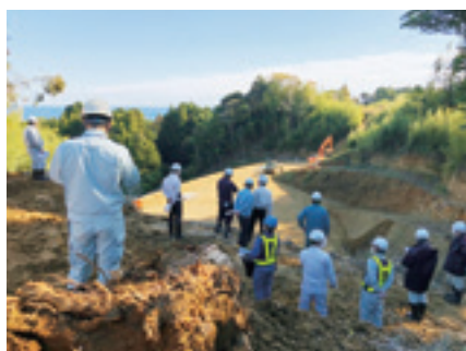
施工状況確認
