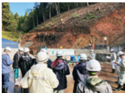
施工状況確認
