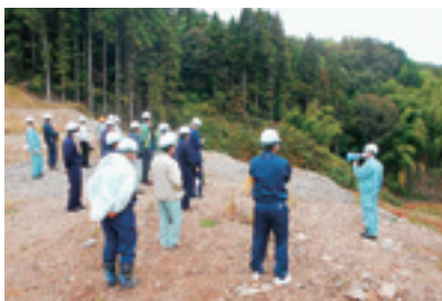
金沢市内川第1建設発生土処理施設
