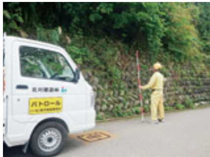
点検パトロール (一社)金沢建設業協会
