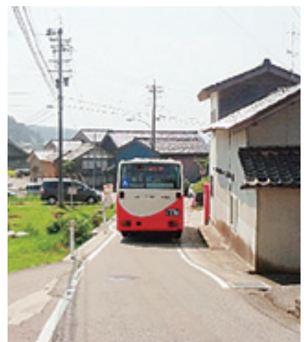
写真-1 幅員が狭くすれ違いが困難
