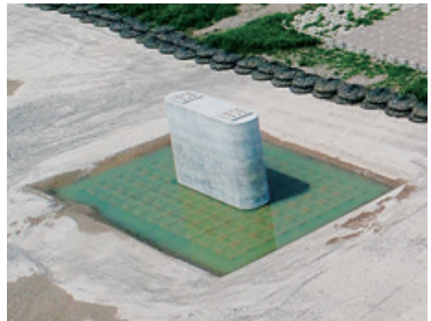
完成写真 (空中写真：上流側よりP2橋脚を望む)
