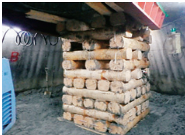
沈下防止対策（上載荷重分散）のサンドル設置状況
