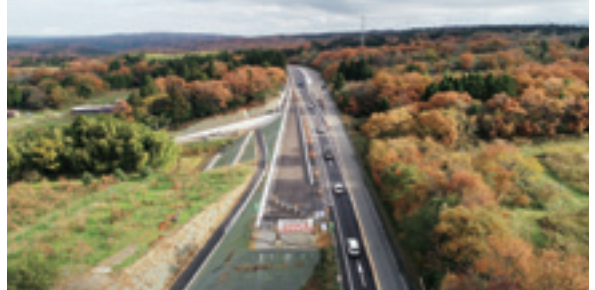
工事完成全景（起点側上空から終点側を望む）
