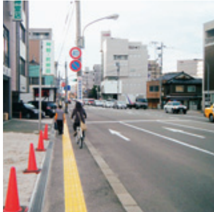
写真-1 整備前の状況
