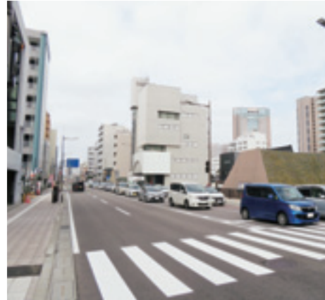
写真-2 整備後の状況
