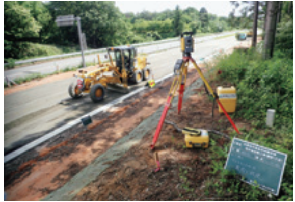
MC グレーダー（自社機械）の施工状況
