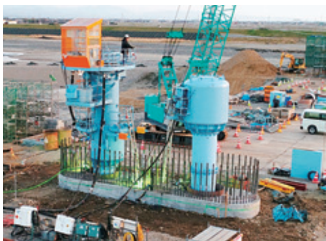
橋脚柱部の沈設状況（右岸側からP2橋脚を望む）
