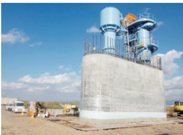
ケーソン部の沈設完了（右岸側からP2橋脚を望む）
