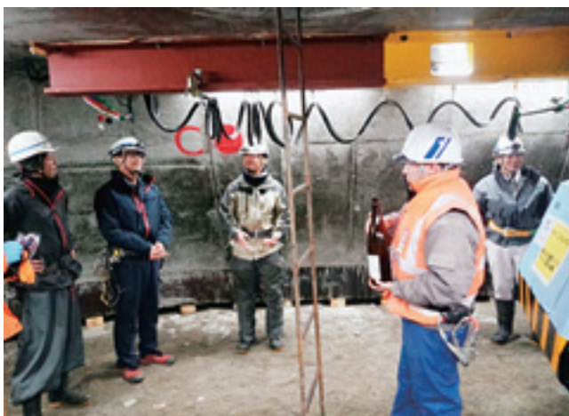
工事開始前のケーソン作業室での安全祈願 (御神酒はもちろん手取川)
