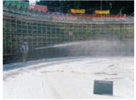
コンクリート養生状況、各種温度測定観測 (1層目：養生マット、2層目：ラミパック 3層目：ブルーシート) 1層目：養生マット設置(散水・湿潤状態)
