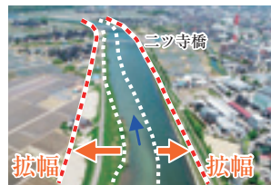
ハード対策の例 (犀川の河川改修)
