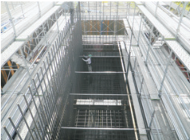
鉄筋組立状況
