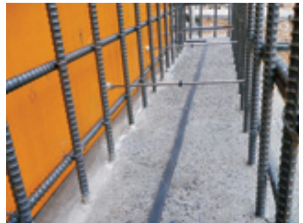
打継目に水膨張止水材の設置
