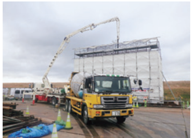
縦壁コンクリート打設状況
