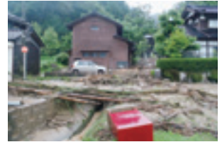
県内の土砂災害(H26羽咋市)
