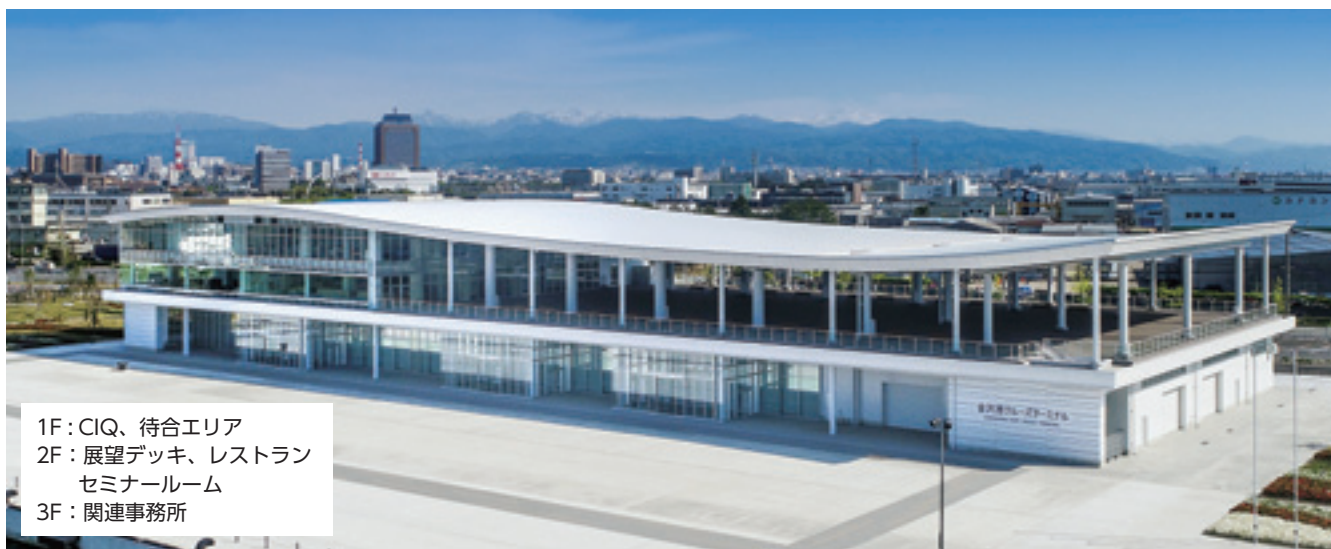
写真－1 金沢港クルーズターミナル
