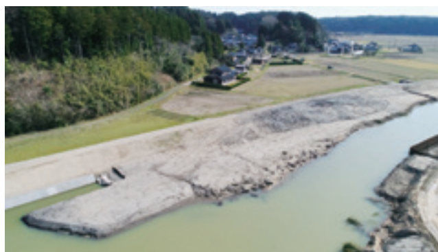
着工前写真（真上）②
