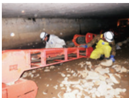
2次掘削—ベルトコンベアによる玉石、堆積ゴミ搬出
