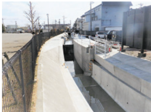
6号落差工一下流から上流を望む
