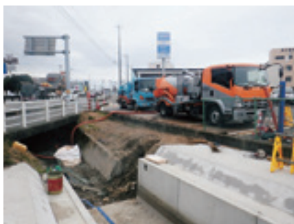
1次掘削—高圧吸引車による細粒土砂搬出
