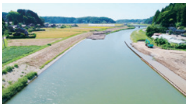
完成写真（真上）①
