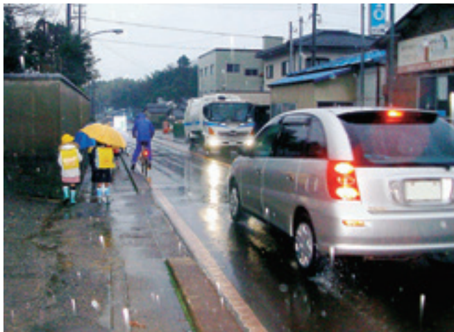
写真-1 整備前の状況
