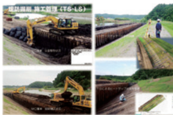
説明文2：堤防掘削 MC施工状況及びTS・LSによる出来形管理の実施
