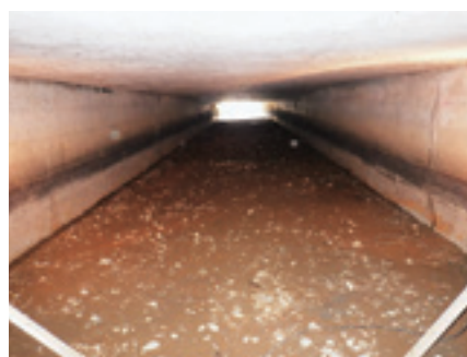
掘削、残土搬出完了 全景
