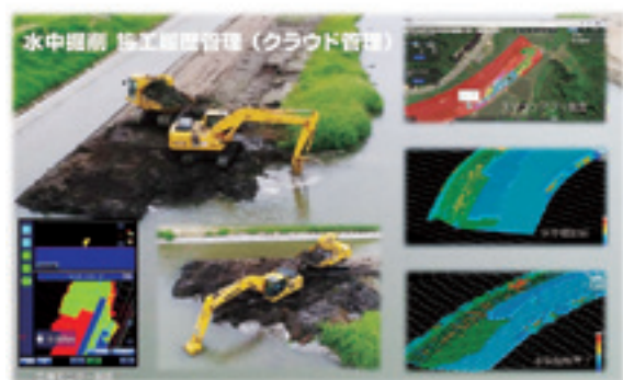
説明文3：水中掘削時、インターネット経由で施工履歴データをクラウドで保管、施工履歴による出来形管理に反映。施工状況もリアルタイムで監視・確認
