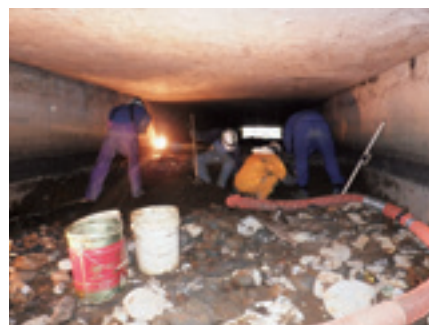
1次掘削—高圧吸引車による細粒土砂搬出
