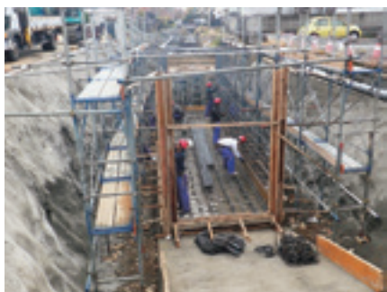
6号落差工 作業状況—モルタル吹付による法面養生
