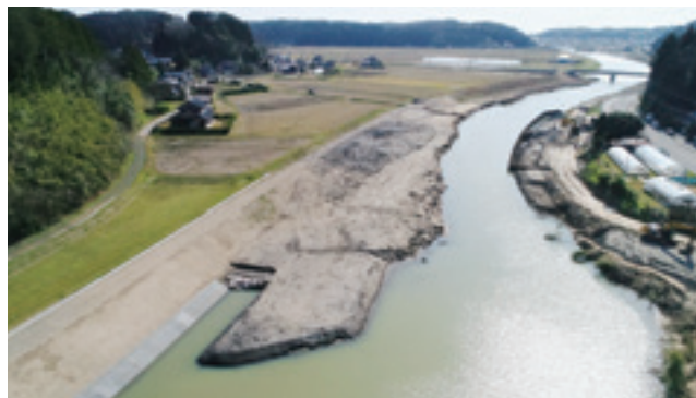
着工前写真（真上）①
