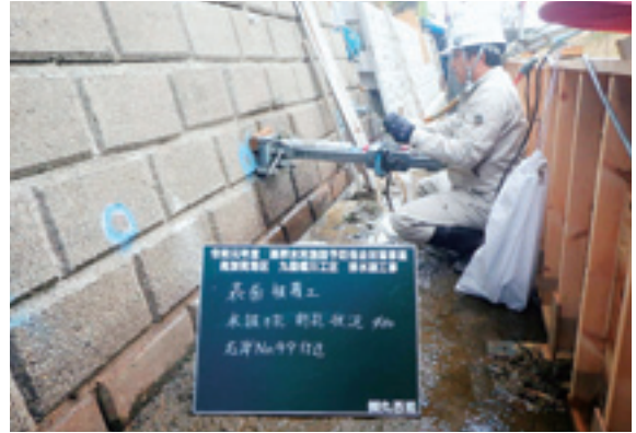
水抜孔設置（削孔状況）
