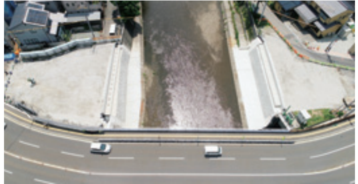
完 成（上空より）
