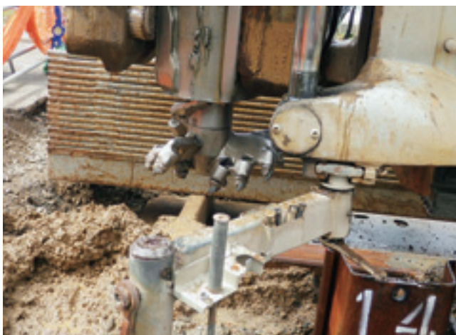
クラッシュパイラーを使用し鋼矢板打設
