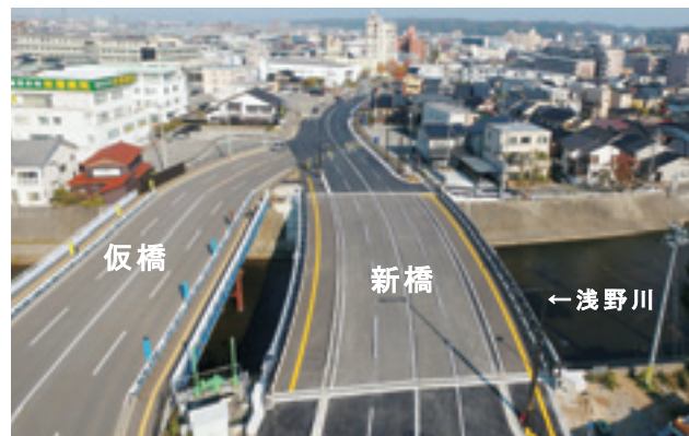
写真-2 新橋完成時の様子
