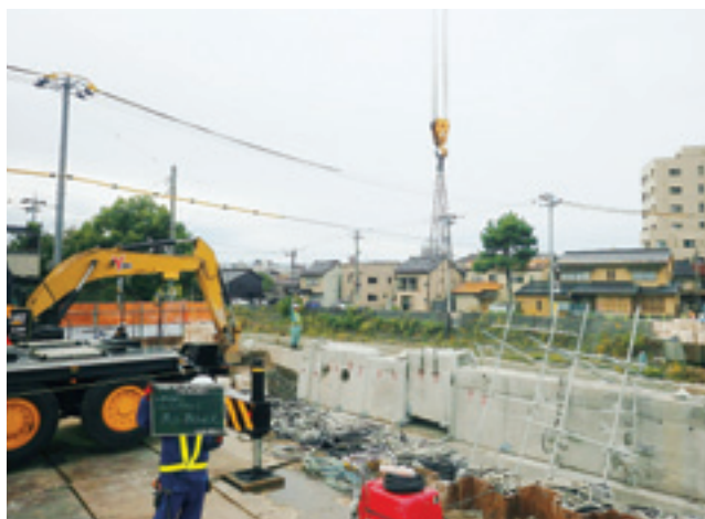
切断された既設橋台を吊込み搬出
