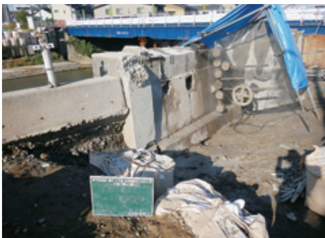
ワイヤーソーを使用し、既設橋台をブロック割り切断
