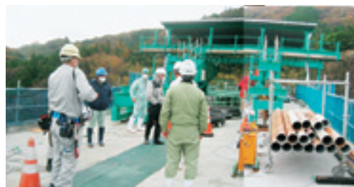
橋梁上部工での施工状況視察
