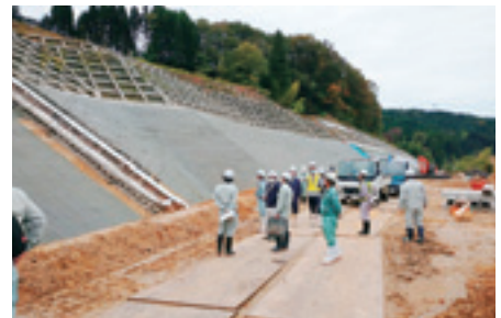
工事点検状況
