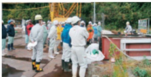
橋脚地上部での工事概要説明
