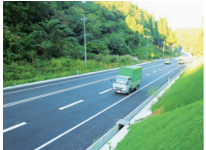
写真-3 ゆずりレーン完成後の状況
