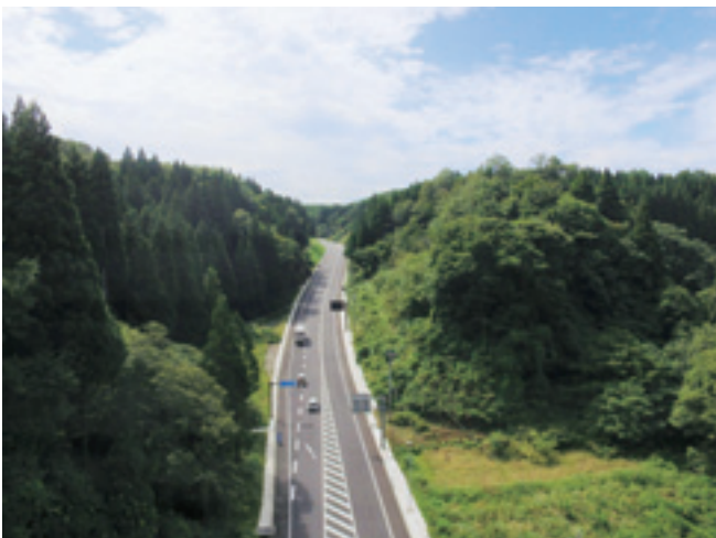
写真-2 ゆずりレーン完成後の状況
