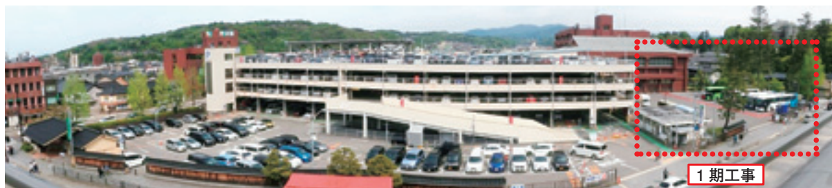
写真-1 兼六駐車場（建て替え前）
