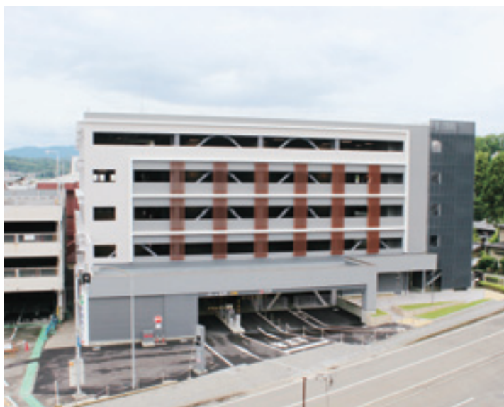
写真-2 第1期工事部分完成写真
