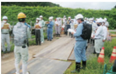
現場安全パトロール
