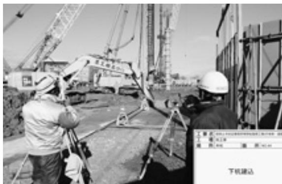
杭工事にPM（パイリングメジャーメント）工法を採用し品質の向上を図った
