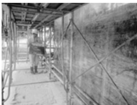
コンクリックエース・ビニールシートによる養生状況
