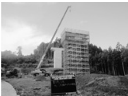
吊荷作業状況（クレーンカメラ使用）
