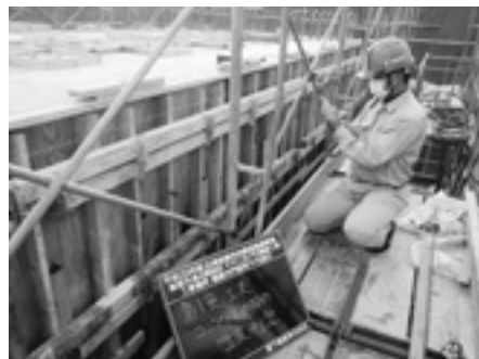
コンクリート内部温度の測定状況
