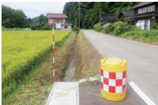
県道特別整備工事（施工前）
