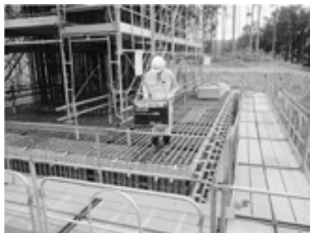
型枠組立前のハイパーネットの取付完了
