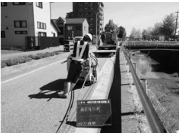
舗装版切断時にウォーターリサイクルの使用
