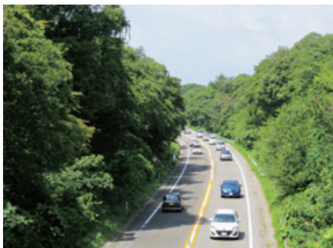
写真-2 2車線区間の状況
