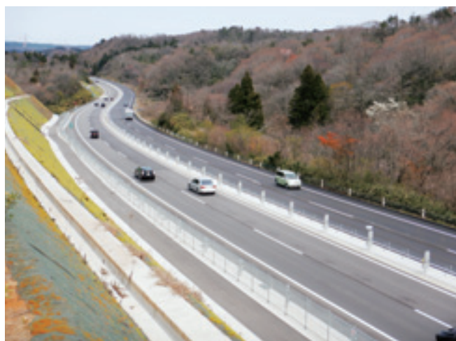
写真-3 今回完成した4車線区間の状況
