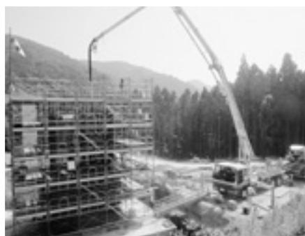
コンクリート打設状況
