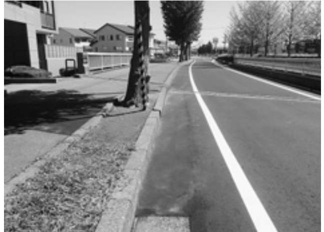
L型側溝上の水溜り箇所を擦り付け
