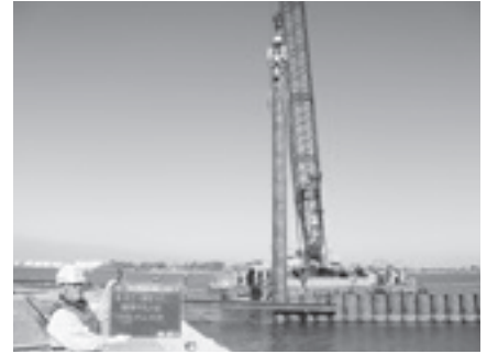
鋼管矢板打設状況 鋼管矢板の打設状況(ウォータージェット 併用パイプロ打設) 2方向から鉛直度の確認を行った
