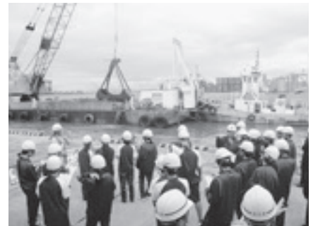
就業体験 高校生の就業体験を受け入れた 工期中2回実施し、2校の生徒に建設業や 土木工事への関心を持ってもらえた
