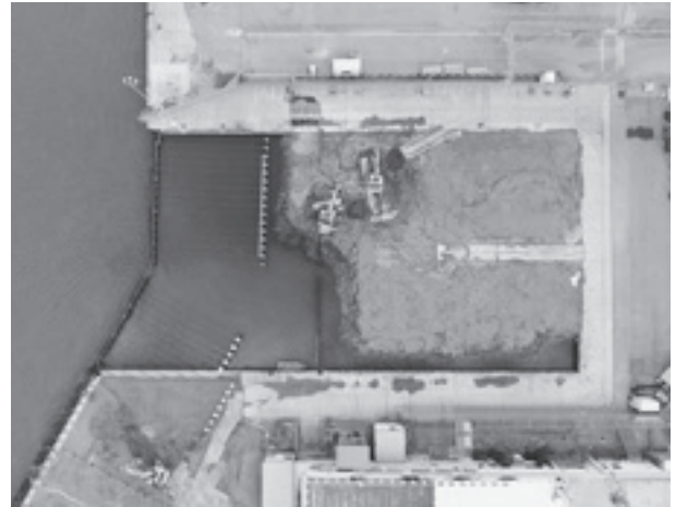
完成写真 背面では埋立て（他工事）が行われている
