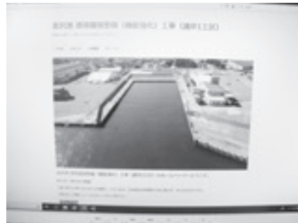
現場ホームページ 現場ホームページを作成し、工事内容や 作業の進捗状況、今後の予定などを広く 一般に公開した
