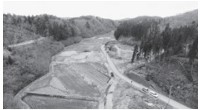
区画整理工事（着工前）
