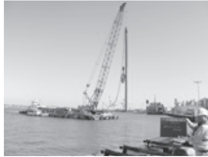
鋼管矢板海上運搬 鋼管矢板の海上運搬 積出し岸壁からこの状態で打設場所まで 台船を移動させた
