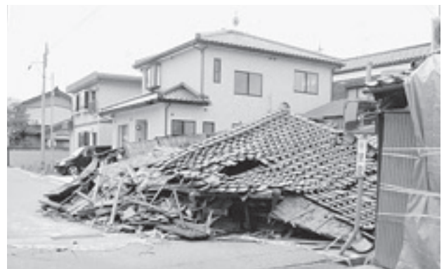
能登半島地震の被災状況
