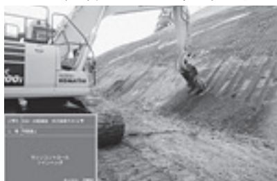
法面整形状況
