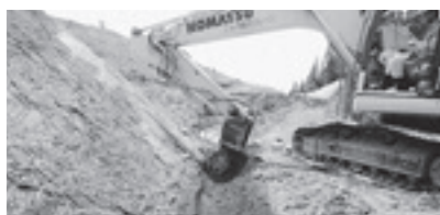
小段排水掘削状況
