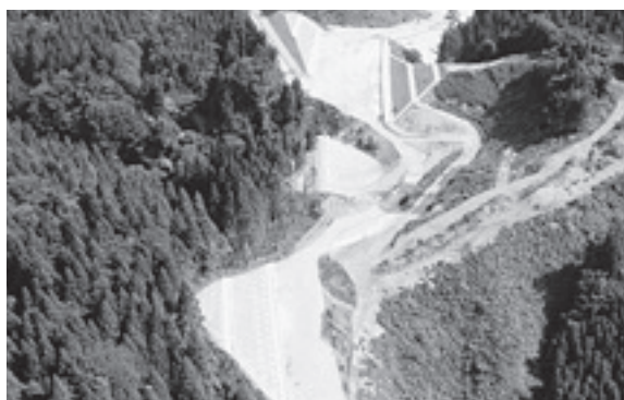
工事範囲全景：南から北方向へ撮影
