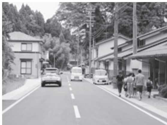
写真-3 完成後の状況（宇留地地内）
