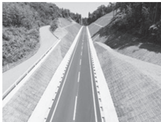
写真-4 完成後の状況（鹿路地内）
