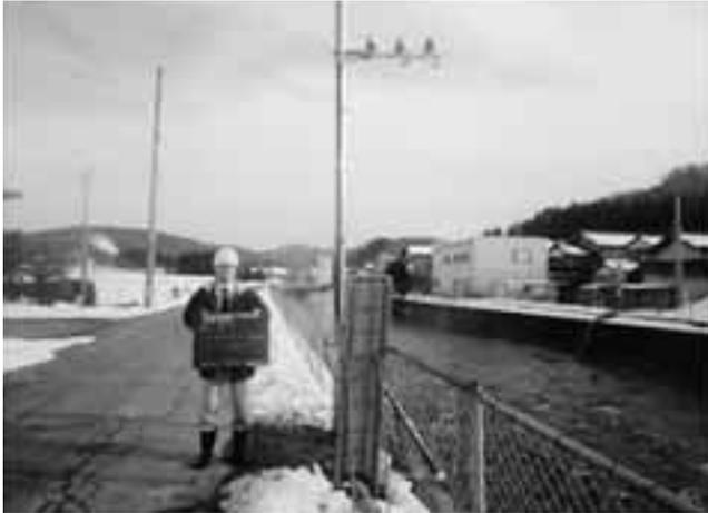
水位センサー設置（水位により回転灯の色が変わる）
