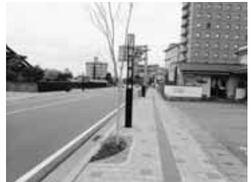
写真 - 3 道路修景
