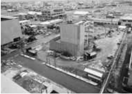
解体工事全景
