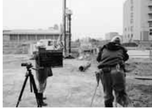
杭工事・ビデオ撮影
