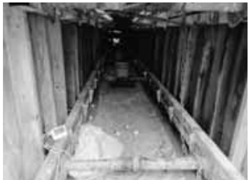
コンクリート温度測定状況
