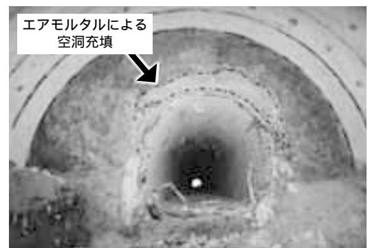
写真 - 3 既設トンネル背面の空隙への充填
