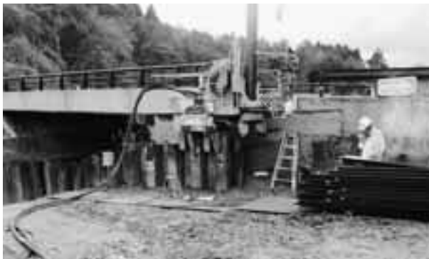
鋼矢板打込状況
