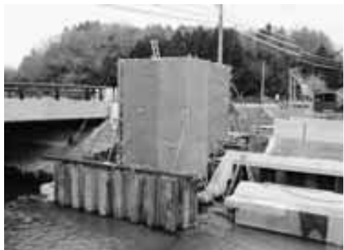
コンクリート養生状況
