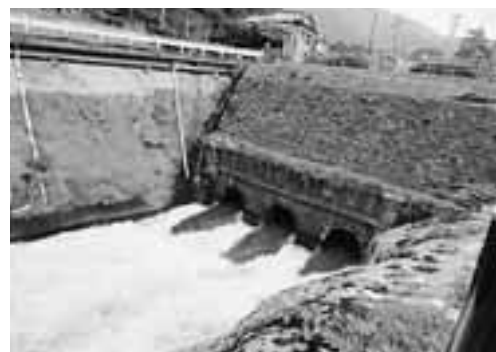
明治36年七ヶ用水取水口（現在に至る）
