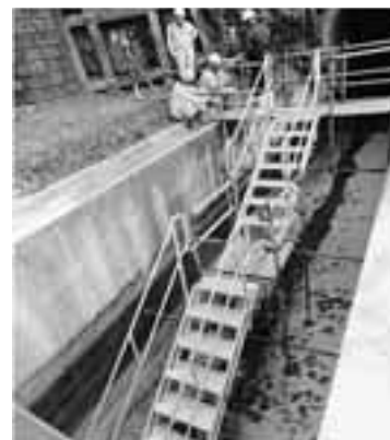
昇降用仮設階段設置
