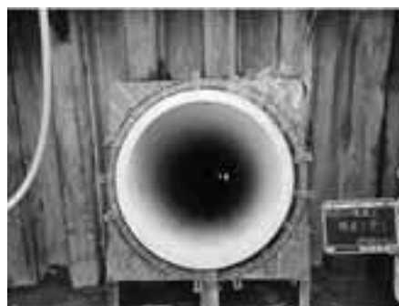
急勾配到達掘進完了
