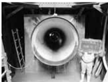
急勾配発進掘進完了
