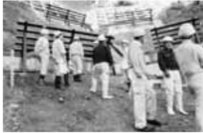
現場安全パトロール
