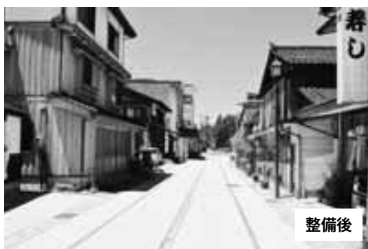
写真-2 整備後の状況
