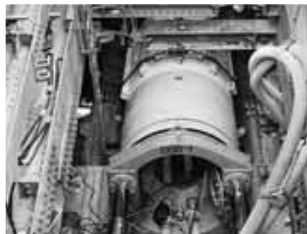
掘進機姿勢制御 シールド筒設置
