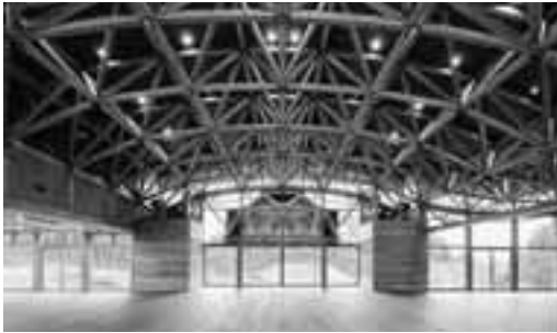
写真 - 5 立体トラス構造
