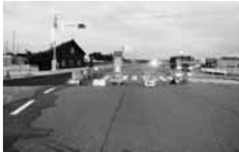
徳光北交差点 安全施設設置状況
