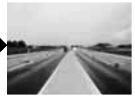
ステップ3 通行帯を内側にし、外側を施工する。
