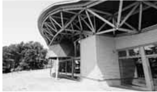
写真 - 4 テラス部分
