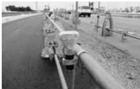
デザインバリケード、誘導灯設置
