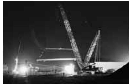
写真 - 2 矢田郷跨線橋の架設状況
