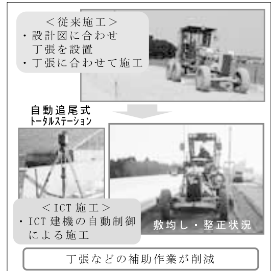
図 - 2 ICT 建設機械による施工
