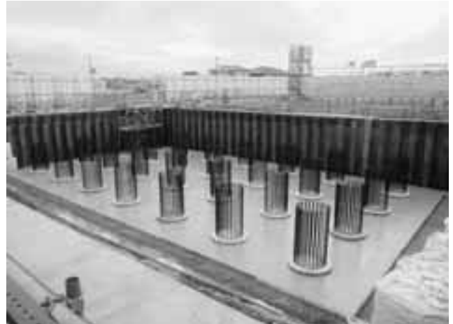
杭頭処理完了
