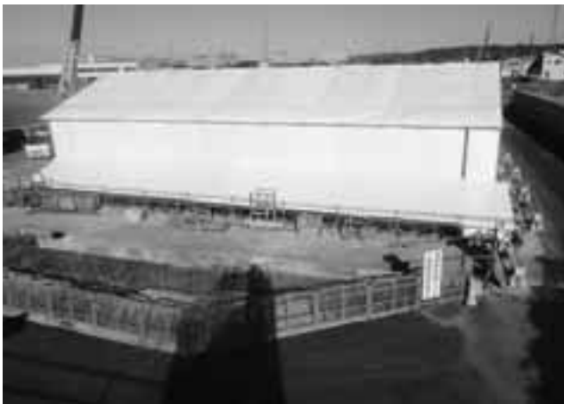
雪寒仮囲い状況
