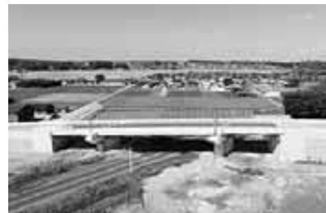
写真 - 1 矢田郷跨線橋
