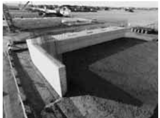
工事完成写真 終点側より起点側を望む
