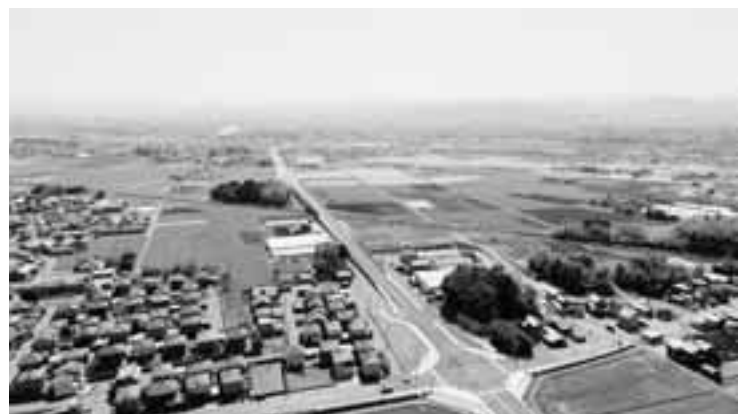
写真 - 4 完成した小松市矢田町～矢田野町間
