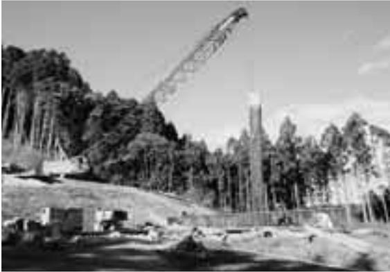
現場打ち杭鉄筋かご挿入状況
