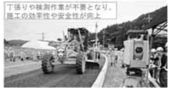
写真 - 1 小間生バイパスでの路盤工
